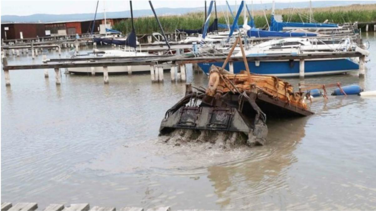
Schlamm wurde in Rust abgesaugt und in ein Rückhaltebecken gepumpt. (Bild: Judt Reinhard)
